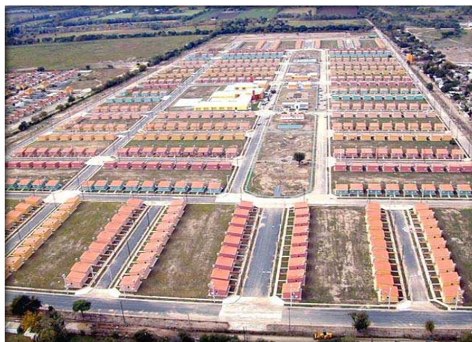
Fotografía I: Imagen aérea de una de las ciudades barrios
