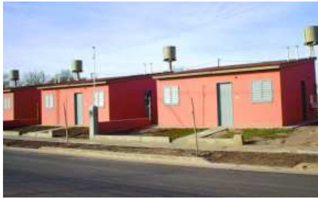
Fotografía III: Viviendas construidas en las ciudades-barrios
